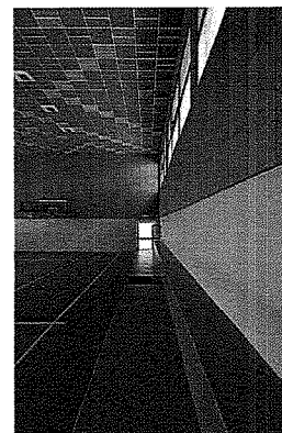
Esempi di correzione acustica in una palestra mediante rivestimenti fonoassorbenti (resistenti alle pallonate) posti a soffitto ed alle pareti
